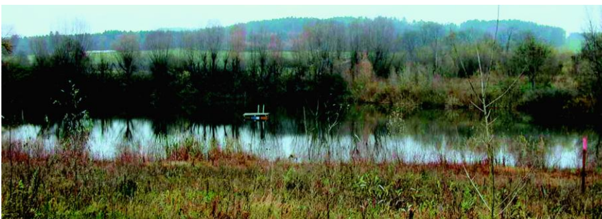
Hochwasserrückhaltebecken Hegmatten, Winterthur
