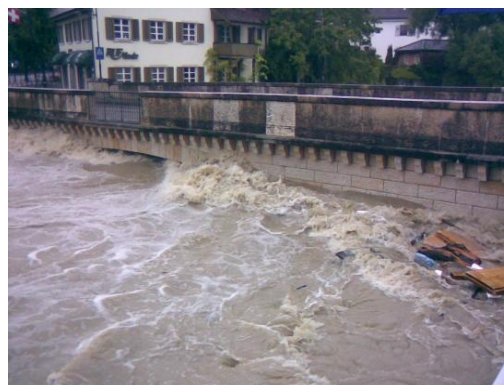
Hochwassersituation bei einer Brücke
